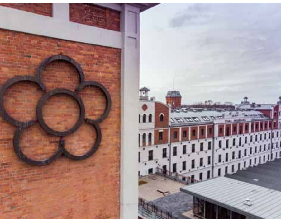
Widok na Starą Przędzalnię
