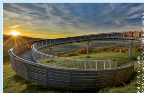
Fot. A. Klimkowski, Kładka rowerowa Zęgiełstów Sulim
