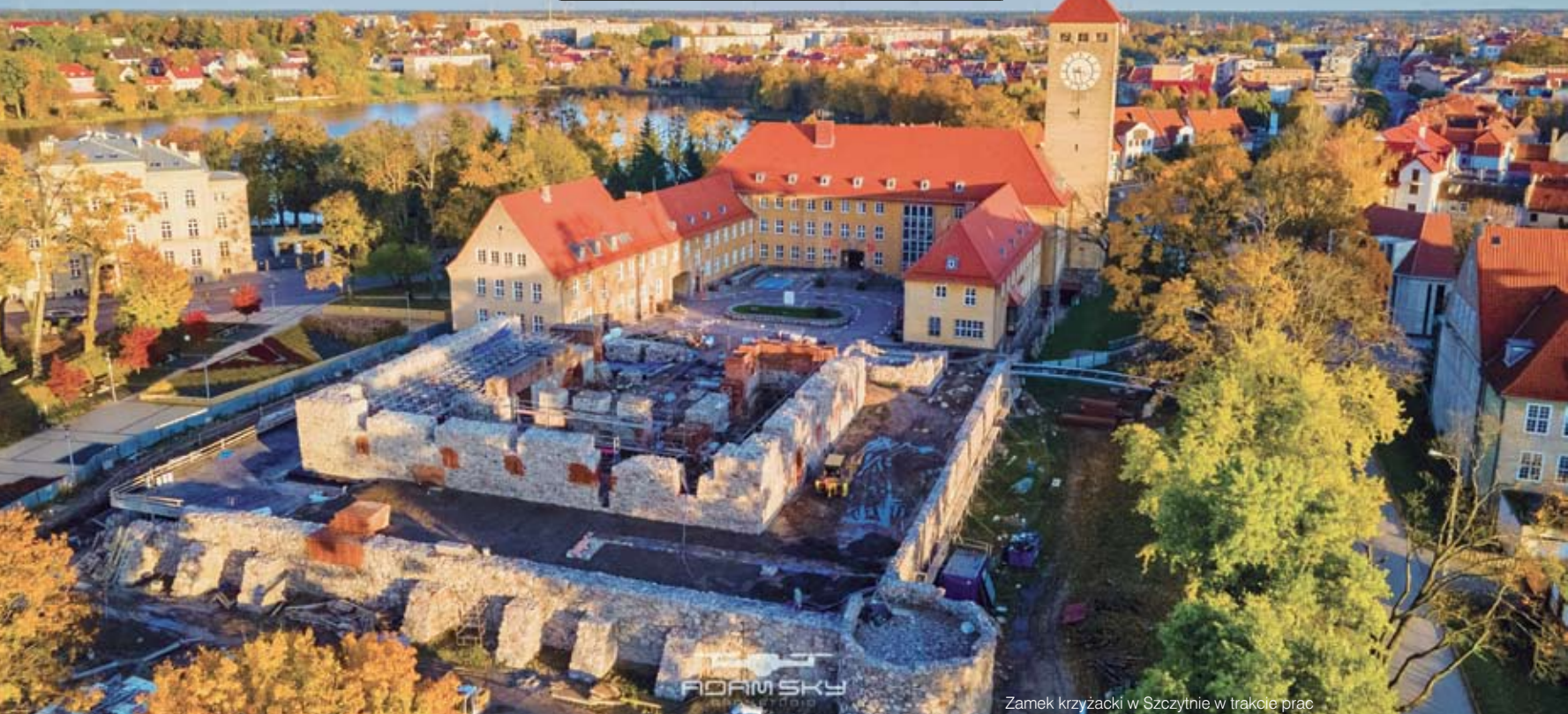
Zamek krzyżacki w Szczytnie, w trakcie prac
