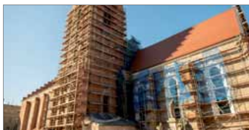
Rewaloryzacja i restauracja elewacji oraz wystroju prowadzona jest zgodnie z wynikami badań konserwatorskich i architektonicznych.
